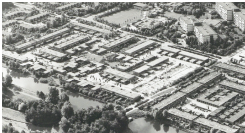
Fig. 4 - Detail van luchtfoto Geerdinkhof, De huizen langs het Ganzenhoefpad zijn in aanbouw, 1986, Beeldbank Stadsarchief Amsterdam
