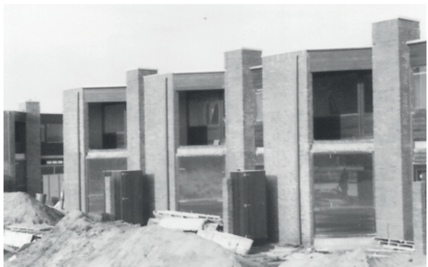
Afb. 5/6/7 - Lage nummers in aanbouw, 1977. Foto's Bram de Graaff
