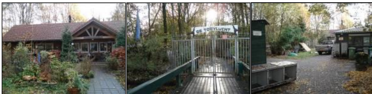
Afbeeldingen: Het terrein van de dierenopvang is toegankelijk via een toegangshek. Op het terrein bevinden zich vele bouwwerken van uiteenlopende afmetingen.
