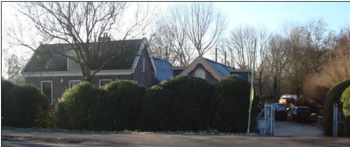
Afbeelding: De bebouwing aan de Provinciale weg 30, dit perceel vormt het ten zuiden van de A9 gelegen deel van het plangebied.
