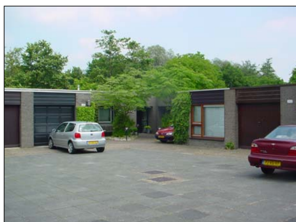
Afbeelding: woning bestaande uit één bouwlaag
