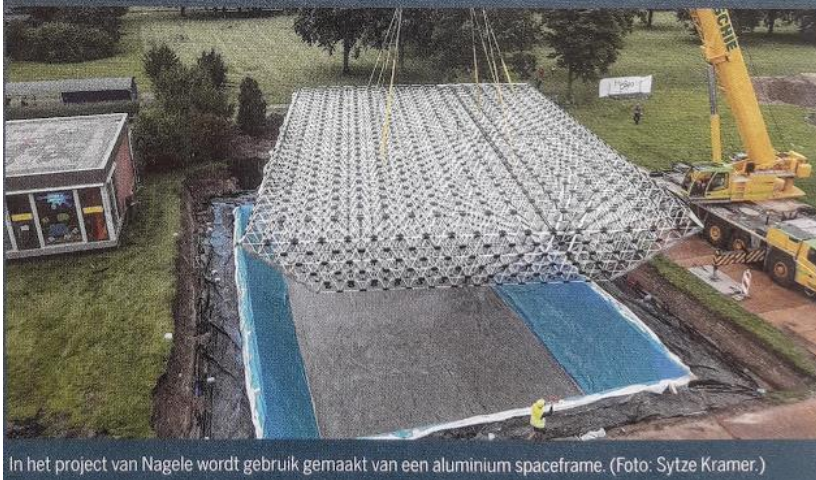
Er wordt een gat gegraven dat wordt bekleed met industriële beschermingsmaterialen en folies. Naast het gat wordt een aluminium spaceframe gebouwd dat vervolgens in het gat wordt geplaatst. (Foto: Sytze Kramer.)
