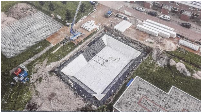
Er wordt een gat gegraven dat wordt bekleed met industriële beschermingsmaterialen en folies. Naast het gat wordt een aluminium spaceframe gebouwd dat vervolgens in het gat wordt geplaatst. (Foto: Sytze Kramer.)
