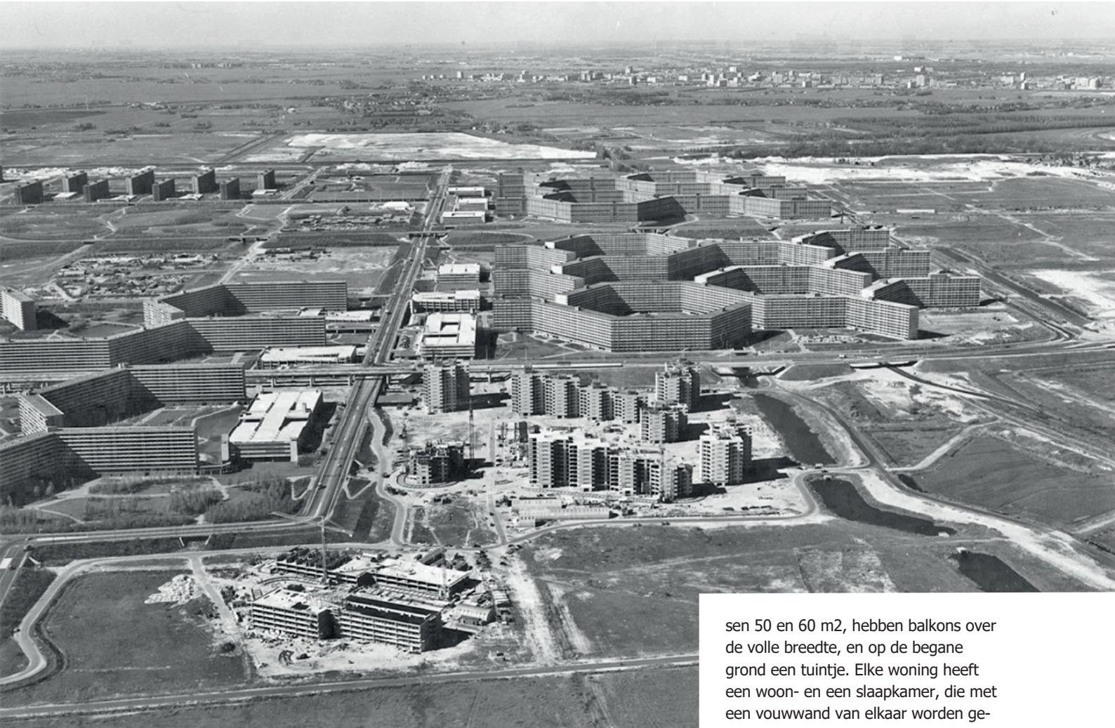
De Garstkamp en daarachter Groenhoven en Gouden Leeuw in aanbouw (1974), Stadsarchief Amsterdam
