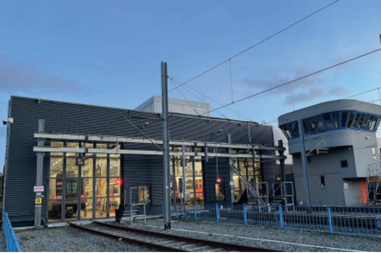
Achtergevel van de uitbreiding van de metrowerkplaats, gezien vanaf het rangeerterrein. Rechts de voormalige verkeerstoren, thans werkruimte voor personeel van onderaannemers.
