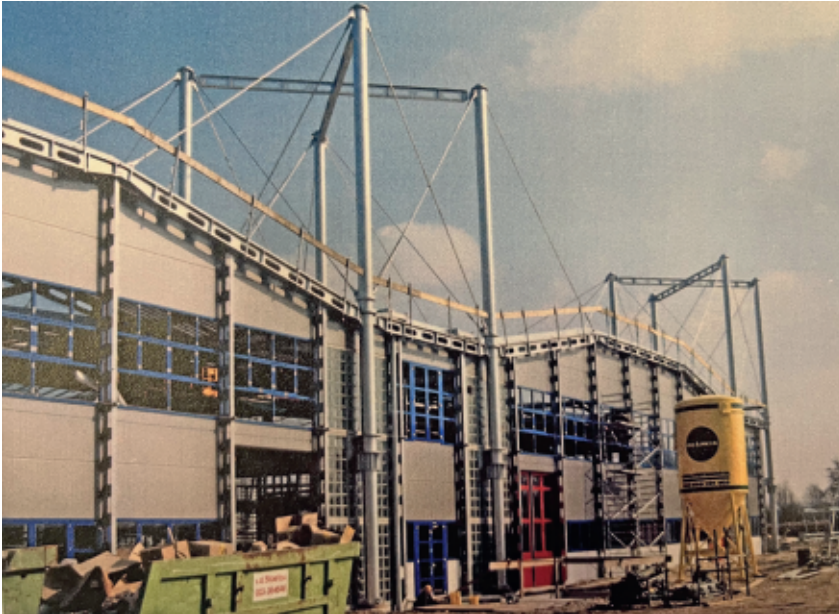
Hoofdwerkplaats tram in aanbouw, uit kwartaalrapportage 1995 GVB, Stadsarchief Amsterdam
